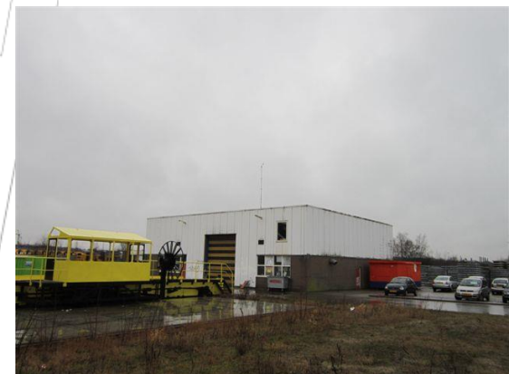
Voormalige laswerkplaats NS
